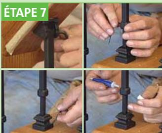
Une fois le barreau bien en place, resserrer les 3 vis de serrage, à la base, sur la tige télescopique et à la tête du nouveau barreau, pour bloquer la hauteur et l'angle du nouveau barreau. Il est recommandé d'utiliser un frein filet liquide sur les vis de serrage. Ne pas appliquer de frein filet sur la tête pivotante tant que celle-ci n'est pas solidement vissée à la rampe.
