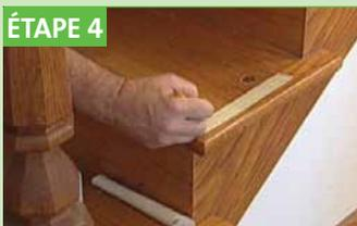
Une fois les barreaux existants retirés, marquer le centre des barreaux originaux sur le ruban à masquer.
