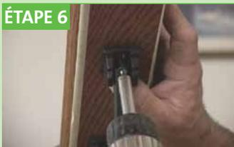
Appliquer l'adhésif de construction sur la surface plane de la tête pivotante. Allonger la tige télescopique du nouveau barreau jusqu'à la rampe et fixer solidement à l'aide de 2 vis.
