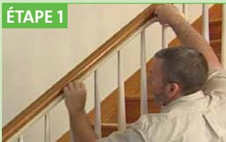
Appliquer le ruban à masquer sur le côté de la rampe et à la base des barreaux existants pour marquer le centre de chacun des barreaux.
