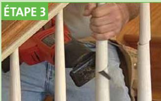
Couper et retirer les barreaux originaux et remplacer par les nouveaux, 4 ou 5 à la fois afin de maintenir le support de la rampe tout au long de l'installation des barreaux.
