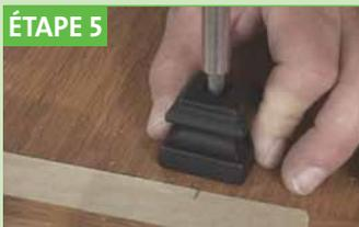
À l'aide de la clé Allen, détendre la vis de serrage à la base du nouveau barreau et séparer la base du barreau. Appliquer l'adhésif de construction sous la base, aligner avec la marque et visser dans la marche. Insérer l'autre partie du barreau dans la base.
