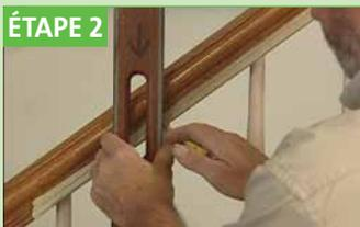
À l'aide d'un niveau, marquer le centre des barreaux originaux dans le haut et dans le bas de chacun.
